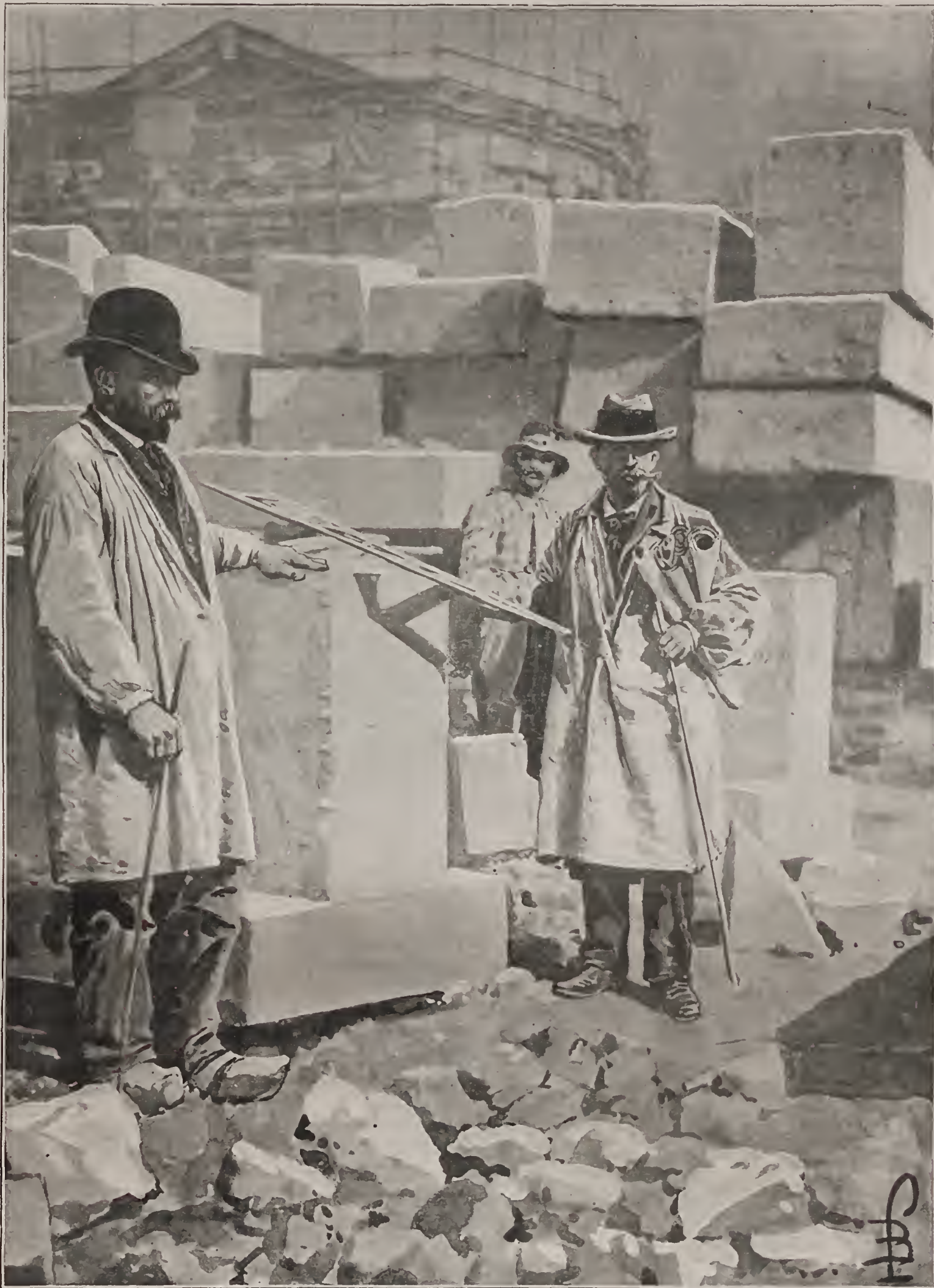
LES TRAVAILLEURS DE L'EXPOSITION. — Appareilleur et compagnon tailleur de pierre. Chantier du Grand Palais des Champs-Élysées.
